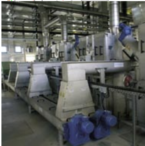
Rechenguttransport
