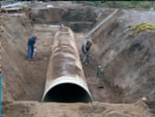
Rohrleitungsverlegung DN 1800
