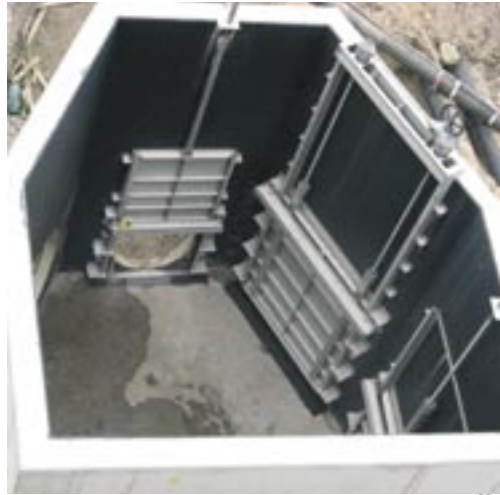
Zusammenführungsschacht
