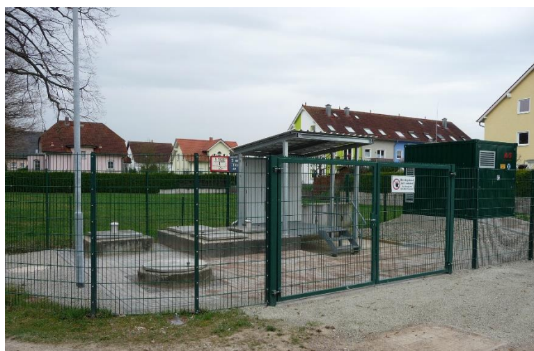
PW Linderbach: Fertigstellung der Netzersatzanlage (NEA)
